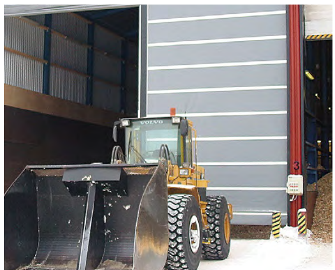
La puerta se puede equipar con un detector de tráfico, que permite que la puerta se abra y se cierre automáticamente.
